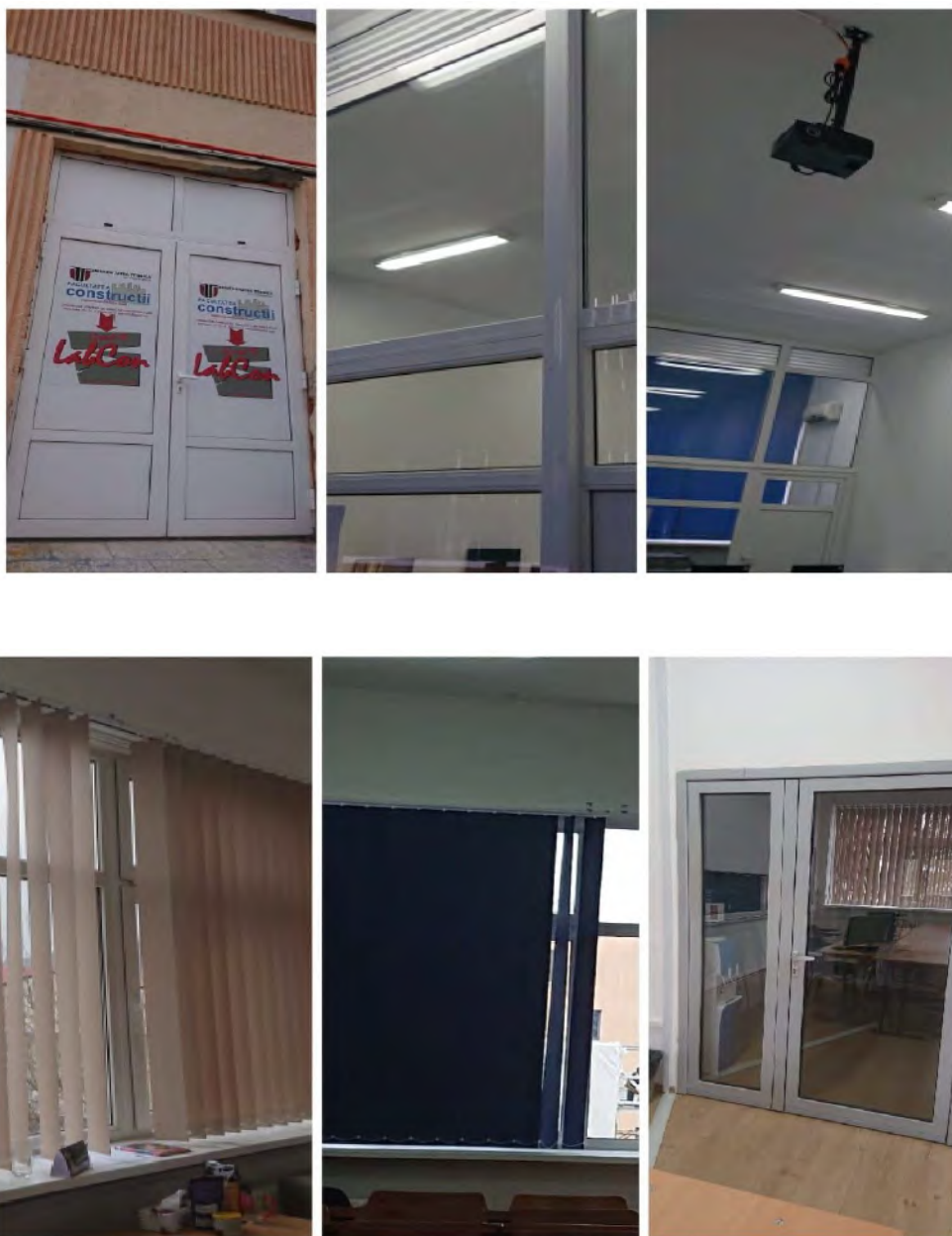
Figura 8.5. Laboratoare L4/3, L4/2, L15, L21 Clădire corp C după modernizare
