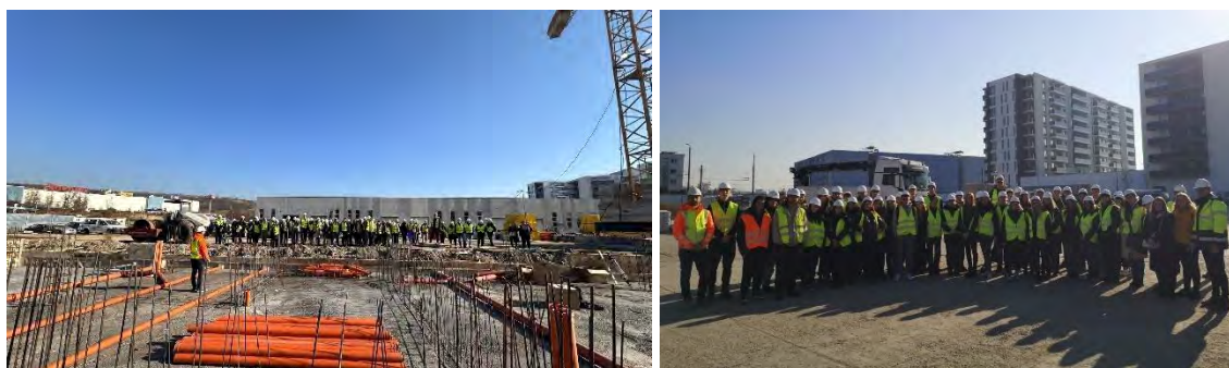
Figura 5.58 - Vizita studenților anului III, Civil Engineering pe șantierul Elite City, 2024
