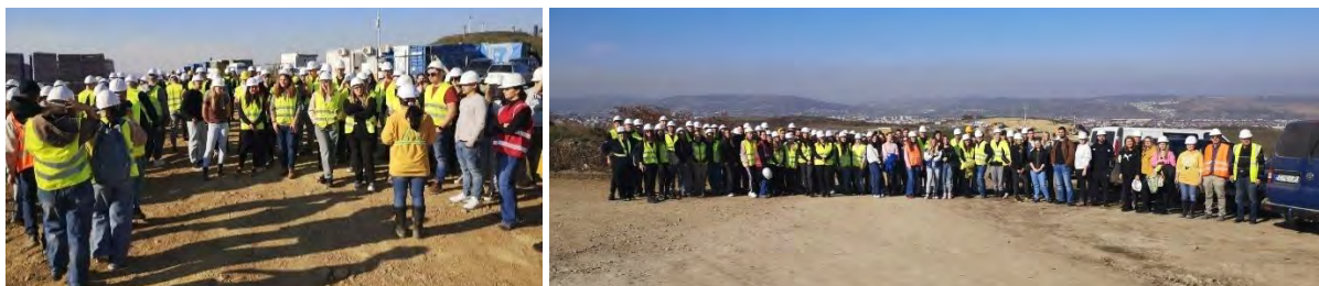
Figura 5.59 - Vizita studenților din anul III, CCIA și IMC pe șantierul Hub-ului Educațional și de Sănătate din Borhanci, Cluj-Napoca, 2024
