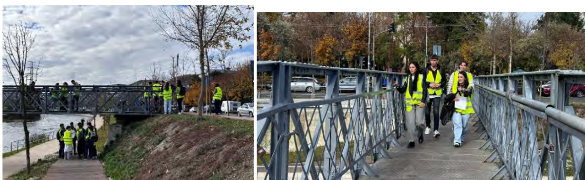
Figura 5.60 - Vizita studenților din anul III CFDP: măsurători pe pasarela pietonală metalică din zona Grigorescu, peste râul Someșul Mic, Cluj-Napoca, 2024
