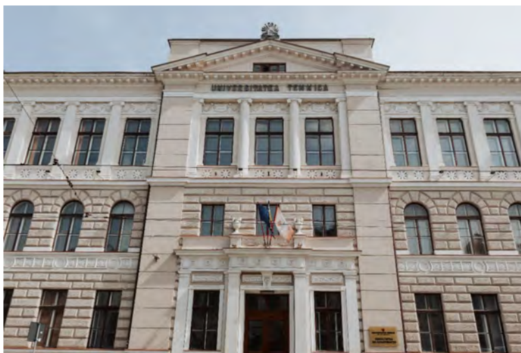
Figura 8 – Fațada clădirii G. Barițiu nr. 25
