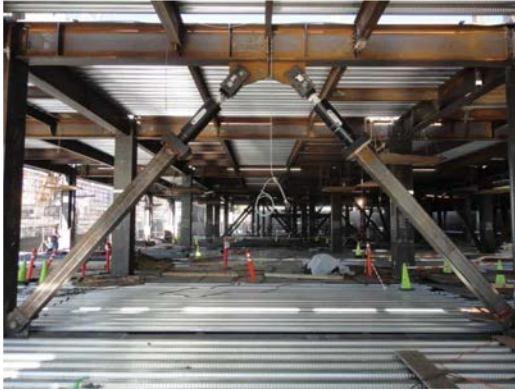
Fig. 4.3. Echipare cu amortizori vâscoși [94]
