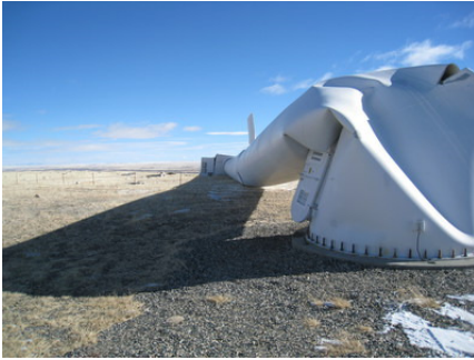
Fig. 2.1. Colapsul cauzat de vânt al unei turbine eoliene [5]
