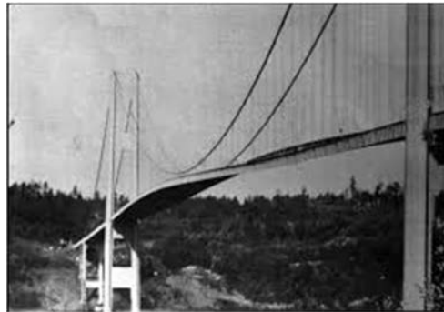
Fig. 2.3. Deformarea tablierului podului Takoma sub acțiunea vântului [7]
