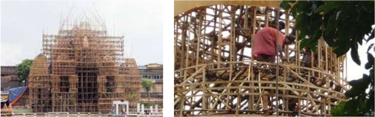
Figure 9. Structure d'habillage de pandals
